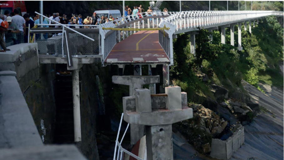
Figura 9 – Tablado pré-moldado apoiado sobre os pilares. Fonte: IG 3 .
