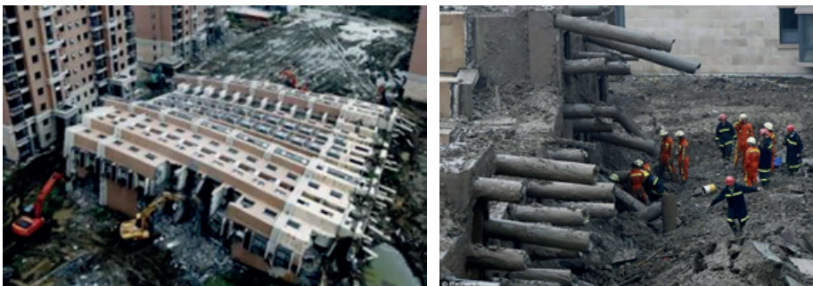
Figura 5 – Edifício residencial desabado em Xangai. Fonte: Folha (2024) 1 .
